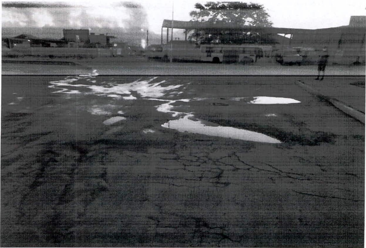
VISITA IN LOCO (ENTRONCAMENTO COM A BA210)
